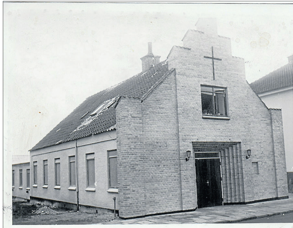
Bethesda Kirken i Kås med ny facade i 1962.
